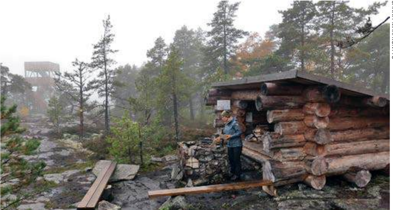
Tulipaikkoja rakentaessa on mietittävä paloturvallisuutta.
